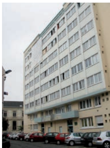
Immeuble collectif Place Verte
