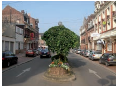
terre-plein central végétalisé à conforter
