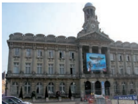
Patrimoine civil : hôtel de ville
