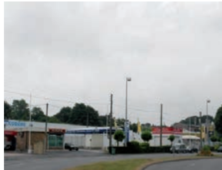
exemple de typologie commerciale rompant l'homogénéité du boulevard
