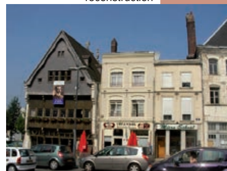
Patrimoine civil : maison espagnole
