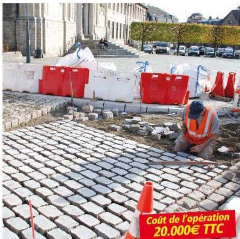
La pavage du bas de la rue Guillaume Du Fay a été refait à neuf.
