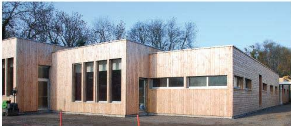
Le nouveau Centre Social vue de la salle de sport Pasteur bénéficie des normes environnementales HQE en vigueur.
