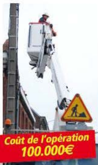
L'entreprise chargée des interventions sur l'éclairage public, est à l'œuvre.
