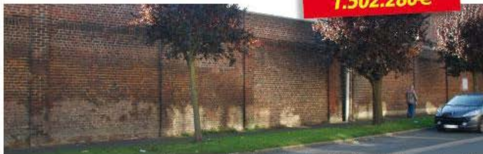
Ce mur, une fois abattu, fera place à la façade de la nouvelle crèche.
