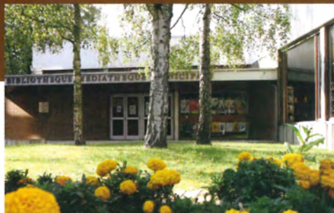
La médiathèque, 2 rue des Archers.
