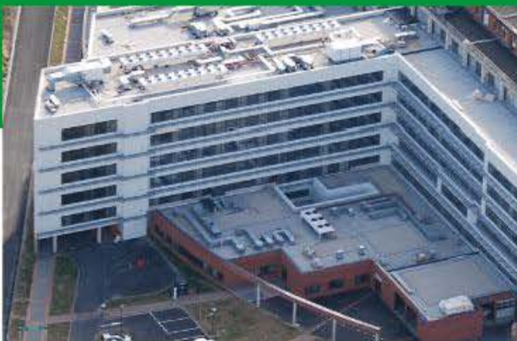
Centre Hospitalier, Avenue de Paris
