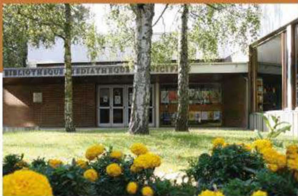
La médiathèque, 2 rue des Archers.
