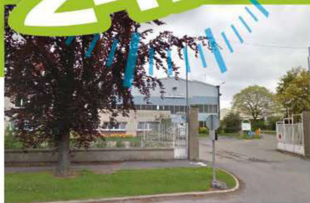
Services techniques municipaux, rue du Champ de Tir.
